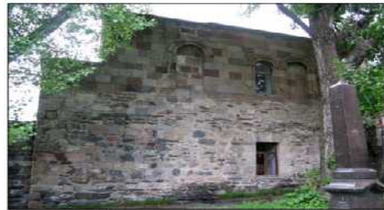
სამხრეთი ფასადი / South Facade
