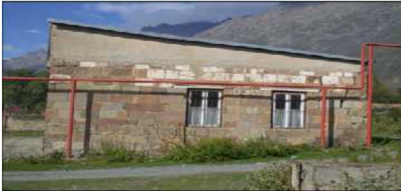
სამხრეთი ფასადი / South Facade
