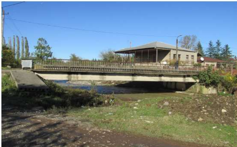
ხედი გორგასალის ქ-ზე (საერთო ხედი) Bridge on Gorgasali st. (General View)
