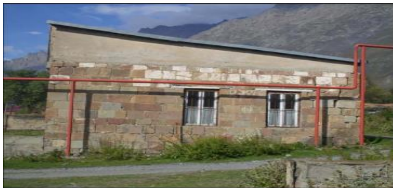
სამხრეთი ფასადი / South Facade
