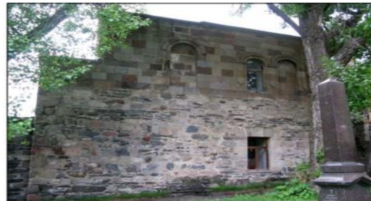
სამხრეთი ფასადი / South Facade
