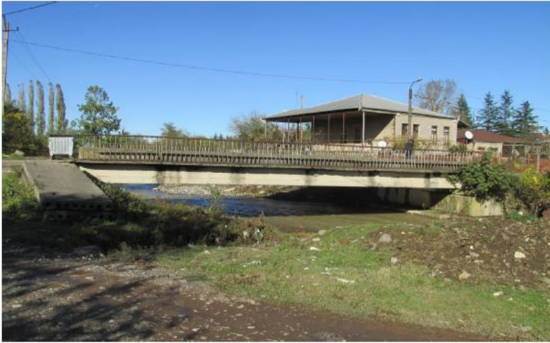
ხედი გორგასალის ქ-ზე (საერთო ხედი) Bridge on Gorgasali st. (General View)
